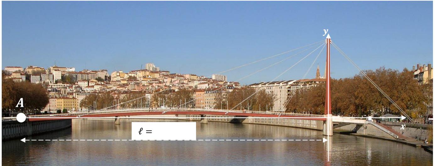
Ce pont est composé d'un tablier en acier, suspendu par 4 câbles en acier. Le tablier a une forme parabolique qui se confond avec la courbe représentative de la fonction  $f$  définie par  $f(x) = -0,001 x^2 - 0,126 x$  dans le repère ci-dessus.  $x$  et  $f(x)$  sont en mètres.
